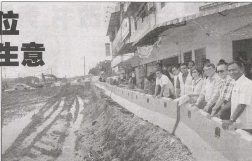
谢云宝（右2起）、梁自坚和颜贝倪在双溪巴高村商业中心前，巡视州际公路提升工程。 -陈启新-
